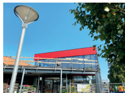
Tilbygning til SuperBrugsen på Frederiksberg.
